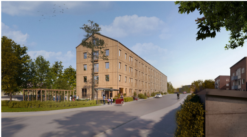
Norra området: Vy över hus A sett söderifrån (White arkitekter).
